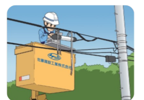
光ファイバー敷設
